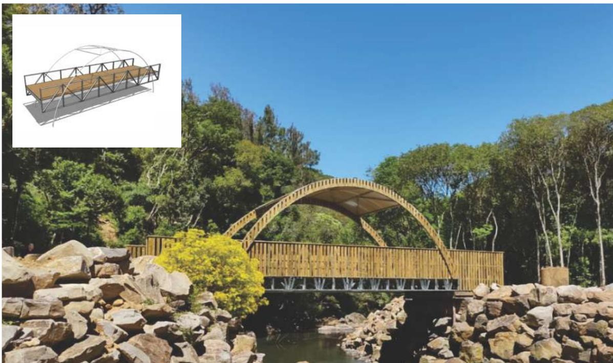
**i** PONTE EM ESTRUTURA METÁLICA GALVANIZADA A FOGO E REVESTIDA DE MADEIRA
